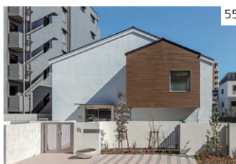
55. にじいろ保育園北砂 東京都江東区、2020年竣工
