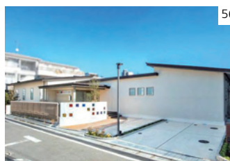
56. ニチエキッズかみいけぶくろ保育園 東京都豊島区、2019年竣工
