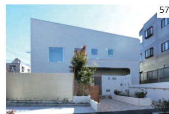
57. ベネッセ 板橋三丁目保育園 東京都板橋区、2018年竣工
